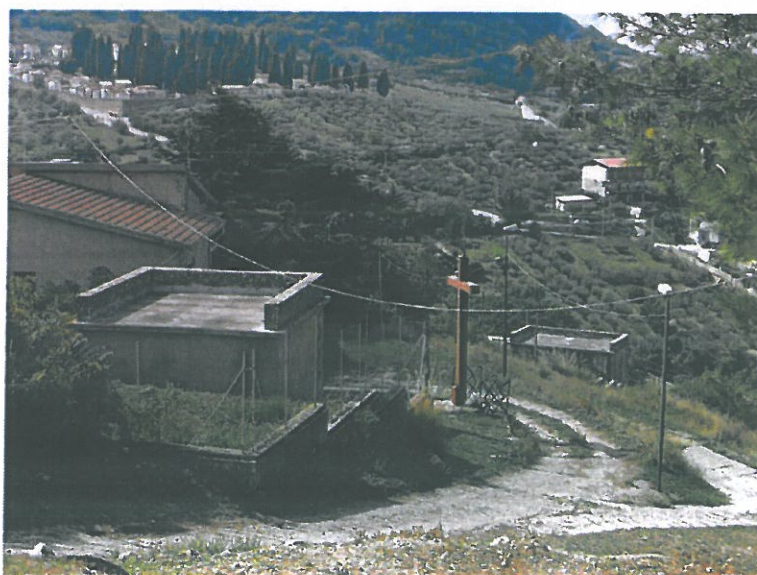
Pozzo Prisa al servizio del Comune S.Stefano Quisquina
