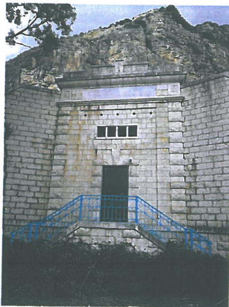
Bottino di riunione Consorzio 3 Sorgenti ( Innamorata 1 e 2 e Finestrelle 1 e 2) S.Stefano Quisquina
